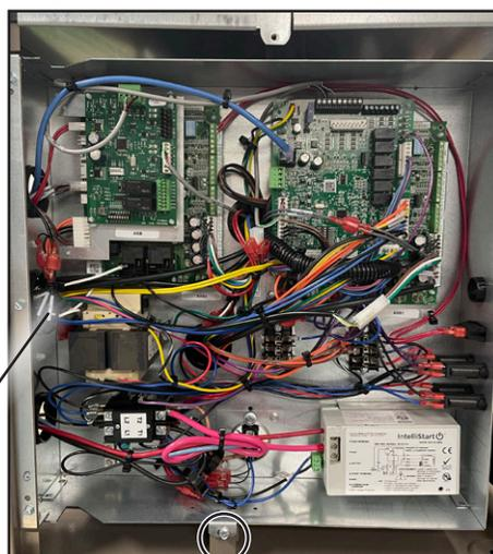
La fixation de mise en terre doit être installée pour assurer la mise en terre adéquate de l'unité.
